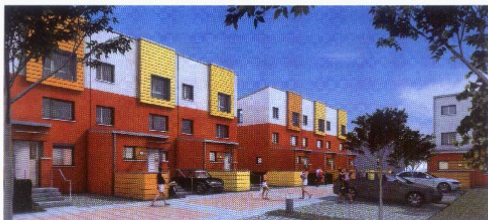
Reihenhäuser, Hannover-Bemerode: Die Wohnbebauung organisiert 21 Reihenhäuser um einen kleinen Platz, an dem auch die Einstellplätze liegen
